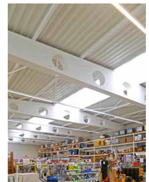
„TopHaus“ Baumarkt, Brixen: Die Klimadecke temperiert den bis zu 7,5 Meter hohen Raum gleichmäßig und effizient. Selbst im Rekordsommer 2015 genossen die Kunden und Mitarbeiter angenehm kühle Räume – bei Außentemperaturen über 35 °C.
