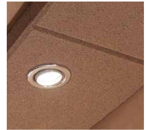
Einbausports sind auch in den Reapor-Körpern möglich
