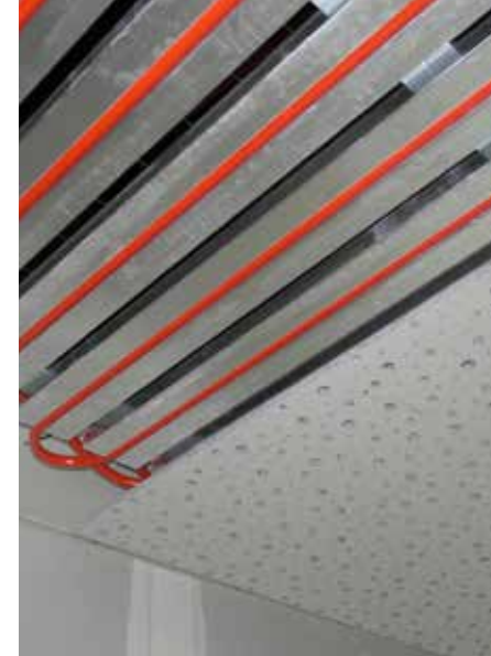
Abgehängte Klimadecke
