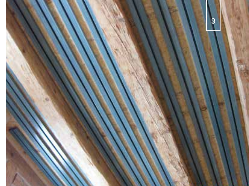
Direktmontage der Klimatop-Profile an einer Balkendecke
