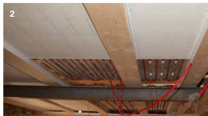
Klimatop-Profile zwischen den Balken verlegt und beplankt
