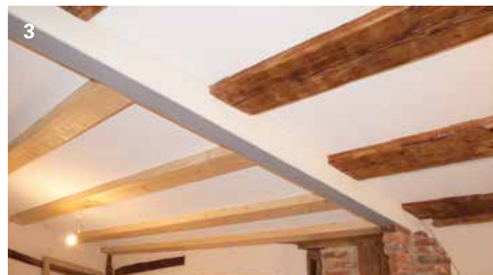
fertige Decke mit originalgetreuer Untersicht
